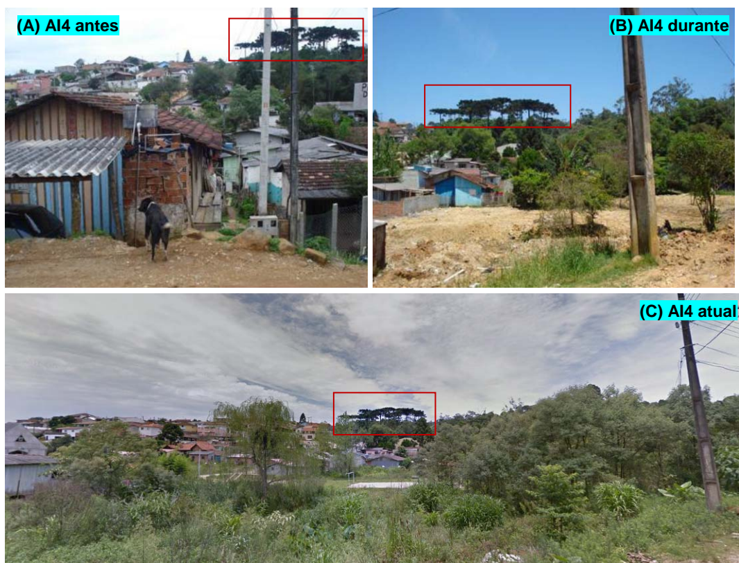
Figura 07 – Etapas da execução do PAC-PPI na AI4. Fotos: Adaptado de (A-B) COHAPAR 2015; (C) Google Earth, 2016.
