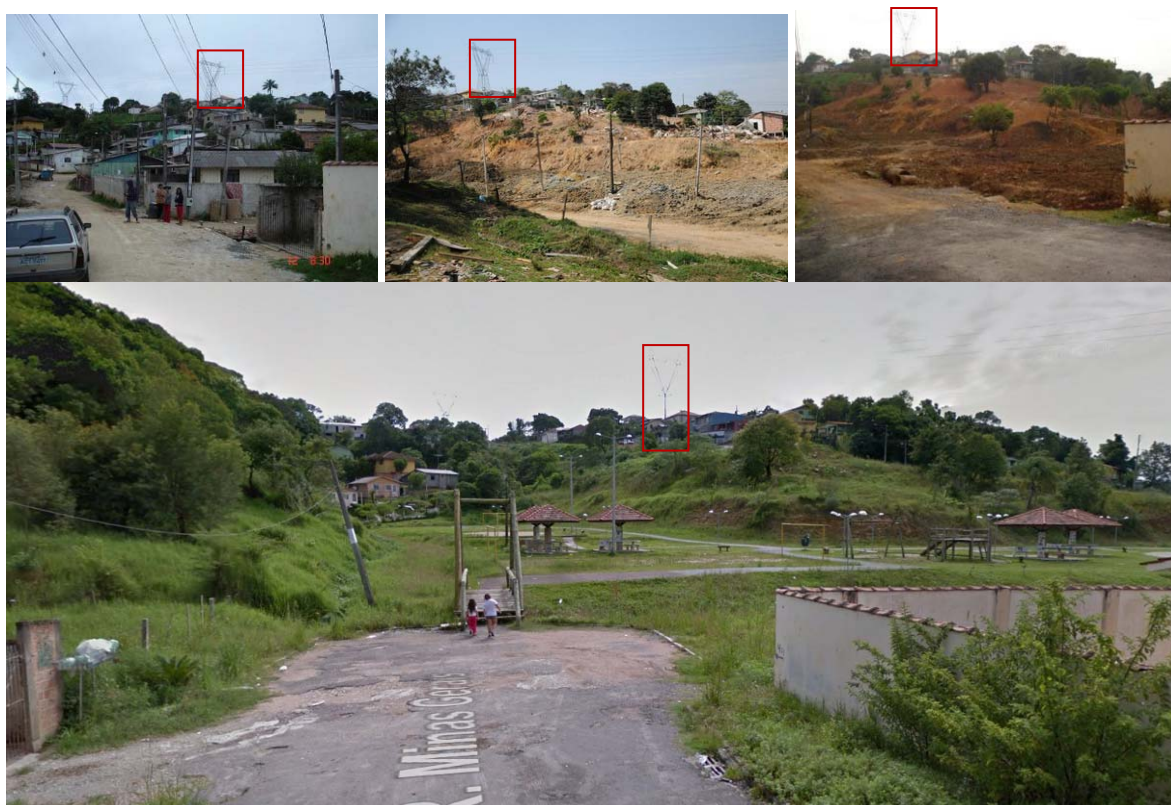
Figura 05 – Etapas da execução do PAC-PPI na AI1. Fotos: (1 e 3) COHAPAR 2015; (2) Caiti tainá, 2010; (4) Google Earth, 2016.
