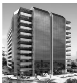
Residencial Francesco Granacci. Fonte: Lares Construções, 2014.
