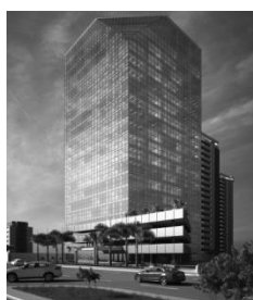
Cielo, Edifício Empresarial Granmonti. Fonte: Contrato
